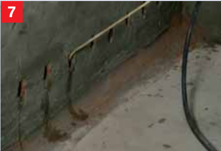
7 Het aanbrengen van Kiesol met een plantenspuit Kiesol kan ook met een plantenspuit worden aangebracht.
