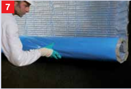
Bescherming van de doorgeharde afdichtingssystemen Na volledige doorharding van het afdichtingssysteem (vooraf testen) moet de gehele afdichting tegen beschadigingen bij het aanvullen worden beschermd.
