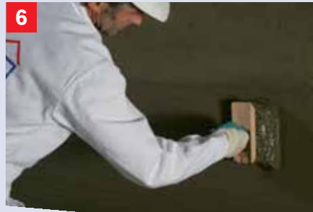
6 Tweede afdichtingslaag De tweede slurrylaag kan op de eerste slurrylaag nat-in-nat worden aangebracht. Afhankelijk van de problematiek eventueel meerdere lagen opzetten.
