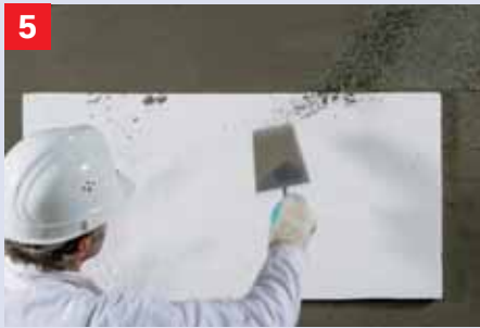
Hechtlaag met Aanbrandmortel De Aanbrandmortel wordt met een dekking van 100% in een laatste natte slurrylaag opgespat.
