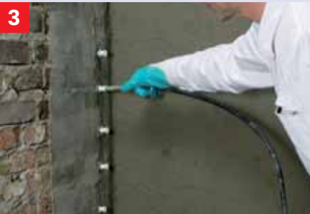
Het inbrengen van Kiesol in het verticale gedeelte Na het plaatsen van de wegwerpnippels kan Kiesol onder lage druk worden aangebracht.
