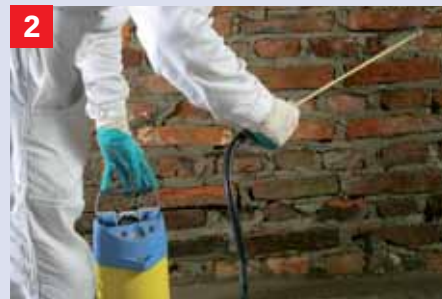
Grondering met Kiesol De grondering Kiesol 1:1 met water wordt met een gloriaspuit gelijkmatig opgesproeid. Sterk zuigende, poreuze ondergronden vooraf met water voornatten.
