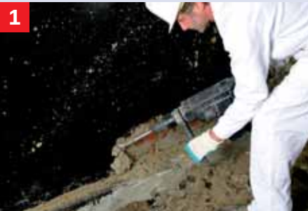
Verwijderen van de oude laag Ter plaatse van de uitkragende vloerplaat die het zwaarst belast wordt, de oude afdichting volledig verwijderen tot op de minerale ondergrond.
