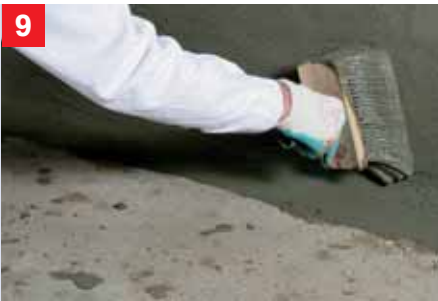
9 Afdichting oppervlakte-injectiezone Na het vullen van de boorgaten de oppervlakte van de geïnjecteerde muur afdichten met Sulfatexmortel.
