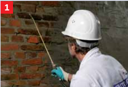
1 Grondering met Kiesol Grondering van de voorbereide ondergrond met Kiesol 1:1 met water. Sterk zuigende ondergronden met water mat voornatten.
