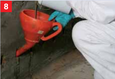
8 Het vullen van de boorgaten met boorgatenvuller Na het beëindigen van de injectiewerkzaamheden de boorgaten vullen met Boorgatenvuller.
