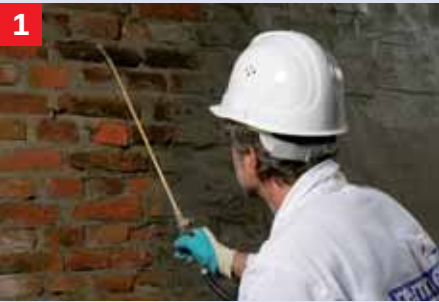
Grondering met Kiesol Kiesol 1:1 met water wordt tenminste 30 cm boven maaiveld en 20 cm onder maaiveld met gloriapuit aangebracht.
