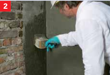
Aansluiting binnenwand verticaal op de buitenmuur Indien het loshakken van de binnenwand niet mogelijk is, wordt de oppervlakte eerst afgedicht, zie bladzijde 34 afbeelding 1–3.
