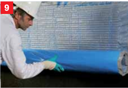
Bescherming van de uitgeharde afdichting met drainagemat Nadat de afdichting volledig is doorgehard (eerst testen), wordt de totale afdichting tegen beschadigingen bij het aanvullen met de Remmers drainagemat afgedekt.
