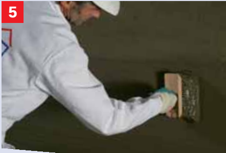
5 Eerste afdichtingslaag met Sulfatexmortel De eerste slurrylaag wordt op de egaliseerlaag van Dichtspachtel opgebracht.
