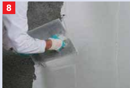
8 Saneerstuc met Saneerputz Antiekwit Na 24 uur wordt de Saneerputz Antiekwit opgezet.
