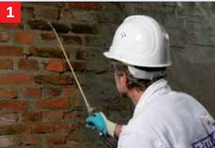
1 Grondering met Kiesol De voorbereide ondergrond wordt eerst met Kiesol 1:1 met water gegrondeerd.
