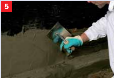
Egalisering met Dichtspachtel Nat-in-nat worden de beschadigingen, onefenheden tot 50 mm in één bewerking met Dichtspachtel geëgaliseerd.
