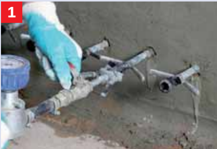
Vullen van de holle ruimte met Boorgatenvuller Bij holle ruimtes in metselwerk wordt via een speciaal nippelsysteem de holle ruimte met Boorgatenvuller gevuld.
