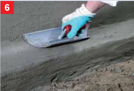
Kim met Dichtspachtel Ook de kim wordt met Dichtspachtel en een speciale spaan nat-in-nat opgezet c.q. aangebracht.
