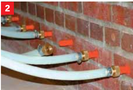
2 Wandaansluiting Eenvoudige schroefverbinding voor de wandaansluiting.
