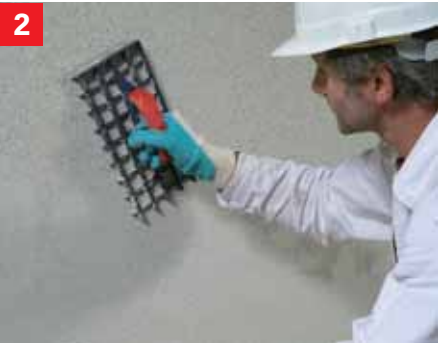
2 „Schaven“ van het oppervlak Met de rasterspaan wordt het reeds aangebrachte restauratiepleisteroppervlak voor het aanbrengen van de Fijnputz gereed gemaakt.
