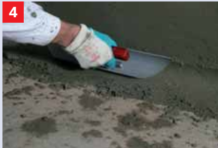
4 Kim met Dichtspachtel De kim wordt met een speciale spaan en Dichtspachtel opgezet.
