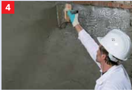
Afdichting met Sulfatexmortel De afdichting met Sulfatexmortel opbrengen d.m.v. kwasten in tenminste twee lagen.
