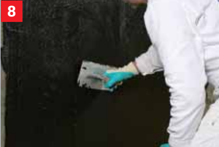
Het aanbrengen van de bitumen-afdichting met Prof Afdichting Na reactie van de hechtlaag wordt Prof Afdichting of een andere bitumencoating in 2 lagen c.q. bewerkingen aangebracht.
