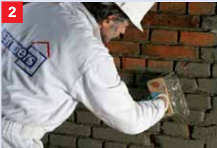
2 Hechtlaag met Sulfatexmortel Gedurende de reactietijd van Kiesol wordt Sulfatexmortel met kwast als hechtlaag aangebracht.
