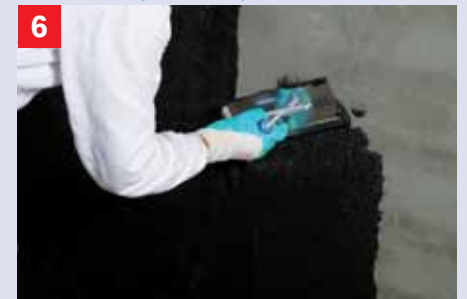
Het opzetten van de eerste bitumenlaag met Prof Afdichting Na droging wordt een eerste afdichtingslaag met Prof Afdichting of een andere bitumen-coating uit het Remmers programma opgezet.
