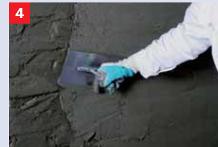
Egalisering met Dichtspachtel Nat-in-nat worden alle oneffenheden, gaten, openingen met Dichtspachtel geëgaliseerd.
