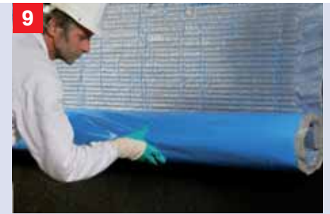
Nadat het afdichtingssysteem volledig is doorgehard wordt de afdichting tegen beschadigingen met de Remmers drainagemat afgedekt.
