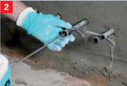
Boorkanalen maken in de Boorgatenvuller Zo gauw de Boorgatenvuller begint te verhar- den, wordt met speciale naalden het injectie- kanaal open gestoken.
