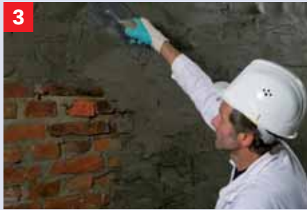
Egalisering met Dichtspachtel Nat-in-nat worden alle oneffenheden met Remmers Dichtspachtel geëgaliseerd.
