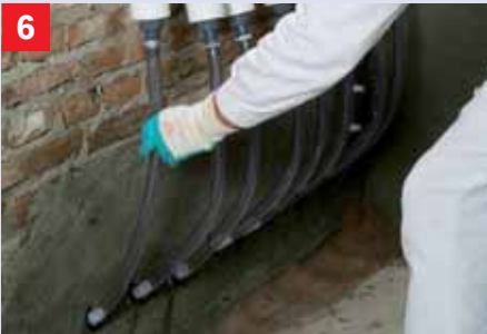
6 Het plaatsen van de Kiesol voorraadtankjes Door gebruik te maken van de voorraadtankjes is het gegarandeerd dat de Kiesol over een langere periode in de muur kan worden opgenomen.
