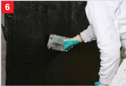
Het opzetten van de bitumenaf-dichting met Prof Afdichting De sokkel-, plintaftichting met Sulfatexmortel wordt tenminste 20 cm overlapt door de Prof Afdichting.
