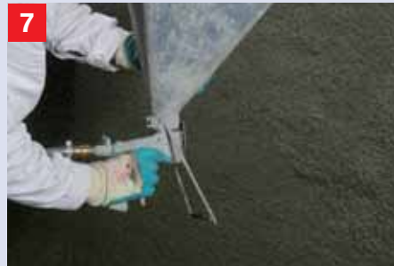
7 Aanbrandlaag met Aanbrandmortel In de aangetrokken maar nog vochtige afdichtingslaag kan de Aanbrandmortel volledig dekkend worden aangebracht.
