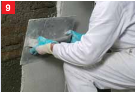
Het aanbrengen van de Saneerputz Na 24 uur kan de Saneerputz op de afgebonden hechtlaag worden aangebracht.
