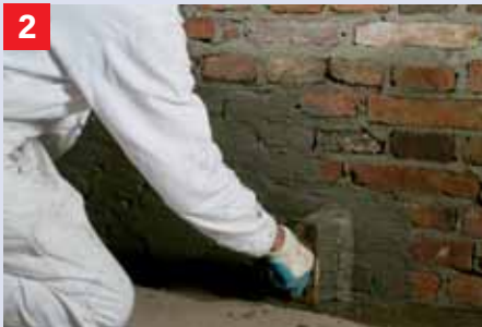
2 Hechtlaag met Sulfatexmortel Tijdens de reactietijd van de Kiesol wordt de Sulfatexmortel met kwast als hechtlaag aangebracht.
