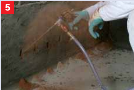
5 Schoonblazen van de boorgaten De gaten voor het vullen schoon blazen om het boormeel en stof uit de gaten te verwijderen.
