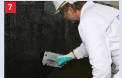
Het opzetten van de tweede laag Zo gauw de eerste laag droog is en niet meer beschadigd kan worden, wordt de tweede laag Prof Afdichting opgebracht. Verbruik, laagdikte e.d. afhankelijk van het probleem en waterdruk.
