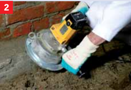
Reinigen uitkragende vloerplaat De uitkragende vloerplaat volledig frezen zodat alle bestanddelen welke de hechting nadelig beïnvloeden verwijderd worden.
