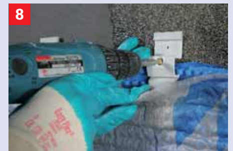
Bevestigen van de clips De clips aan de bovenzijde van de afdichting schroeven boven maaiveld.
