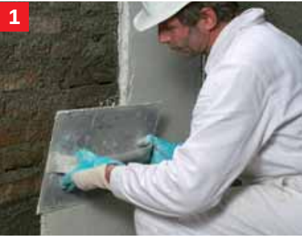
1 Opbrengen van restauratiepleister Afhankelijk van de opbouw wordt het gekozen Remmers systeem op z'n vroegst na 24 uur aangebracht. Tussenschichten moeten door deze ruw te kammen terwijl ze vers zijn, geprepareerd worden voor de volgende laag,
