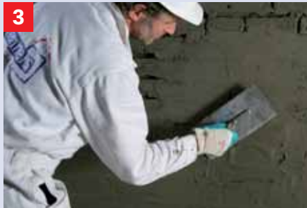
3 Egalisering met Dichtspachtel In de natte hechtlaag wordt de Dichtspachtel aangebracht.
