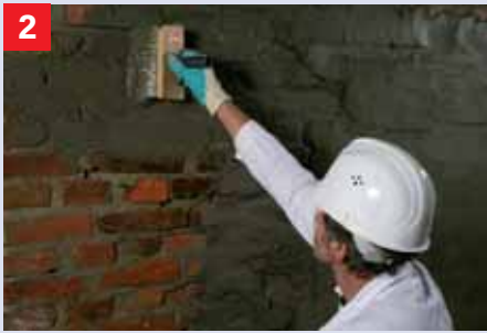
Hechtlaag met Sulfatexmortel Binnen de reactietijd van Kiesol wordt de hechtlaag met Sulfatexmortel met kwast aangebracht.
