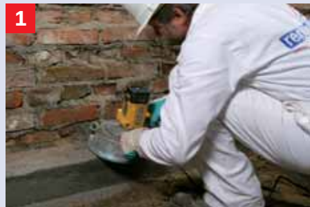
Voorbewerking De diktezijde van de uitkragende vloerplaat op-ruwen c.q. frezen. Slecht hechtende ondergronden door stralen, bijv. de Rotec-Nevelstraaltechniek of schuurmachine en frees schoonmaken.
