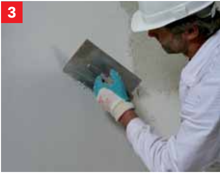
3 Opbrengen van de Fijnspachtel Op de met de rasterspaan voorbereide ondergrond wordt de Fijnputz in een maximale laagdikte van 5 mm opgebracht en met schuurbord afgewerkt.
