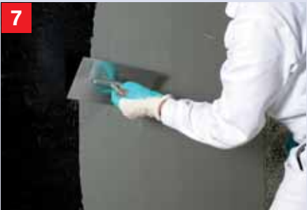
Hechtlaag met Elastomortel 1K De hoog kunststofveredelde hechtlaag wordt met Remmers Elastomortel 1K met spaan dun, volledig dekkend opgebracht.
