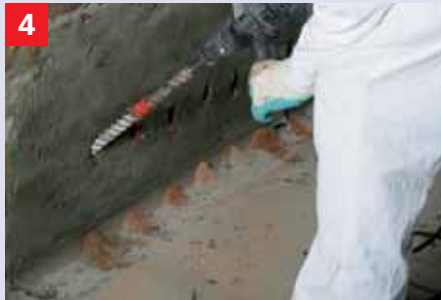
4 Boorgaten aanbrengen Na het afdichten van het oppervlak van de injectiezone, gaten boren, maximale afstand 12,5 cm met een diameter van 30 mm, schuin naar beneden onder een hoek van 45°.
