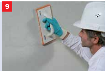
9 Afwerking Saneerputz De Saneerputz moet nadat deze begint aan te trekken met sponsbord en een beetje water geschuurd worden of met rasterspaan bewerken en afgewerkt worden met Fijnputz.
