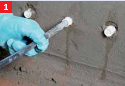
Het inbrengen van Kiesol in het horizontale gedeelte Indien geen vulling van de holle ruimte noodzakelijk is, kunnen wegwerpnippels in de boorgaten worden geplaatst.
