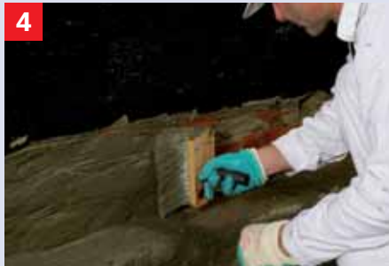
Hechtlaag met Sulfatexmortel Binnen de reactietijd van Kiesol wordt de hechtlaag met Sulfatexmortel d.m.v. een kwast opgebracht.
